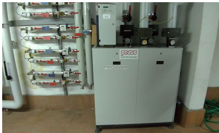
Fig. 2 – centralina di scambio rete teleriscaldamento
