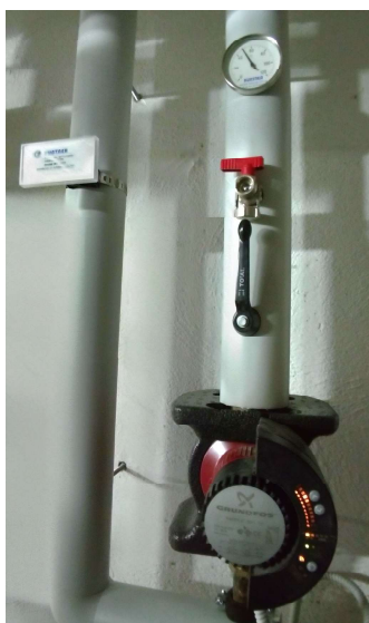
Fig. 4 – condotto ricircolo acqua calda sanitaria dotato di presa per prelievo campioni
