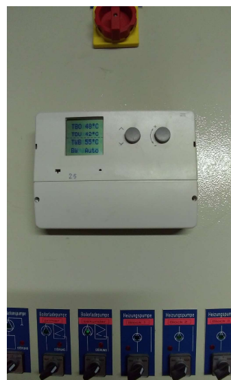
Fig. 5 – centralina di controllo
