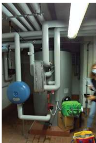
Fig. 3 – boiler accumulo acqua calda sanitaria e scambiatore esterno
